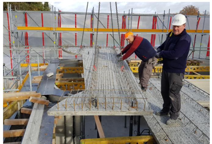
↑ Bild 5: Bauprozess mit eingehängter Decke
