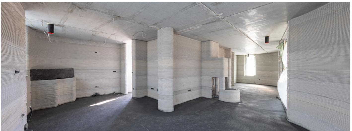
↑ Bild 9: Erdgeschoss mit Kamin des 3D-gedruckten Hauses in Beckum
