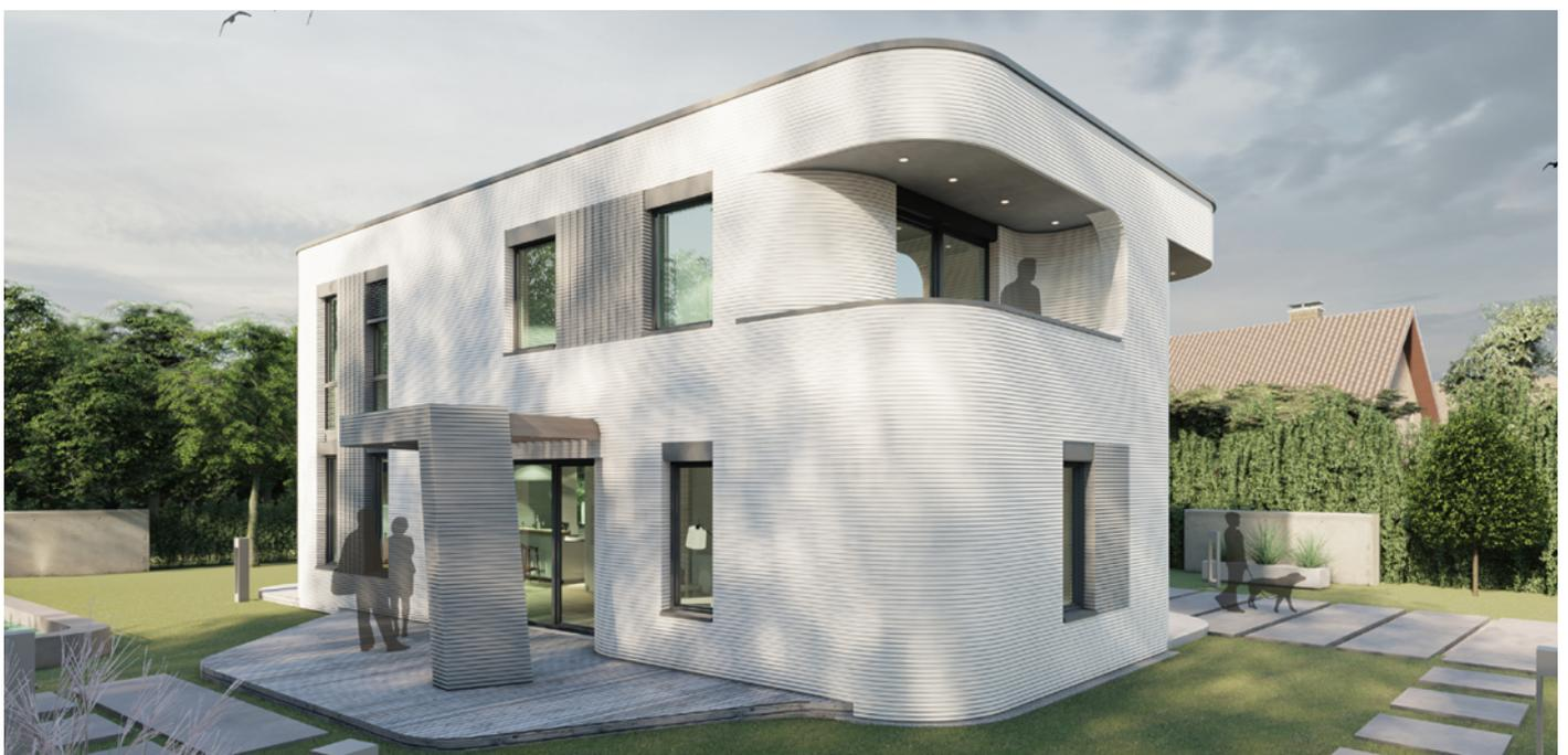
↑ Bild 3: Animation des ersten in Deutschland mittels 3D-Betondruck realisierten Gebäudes
