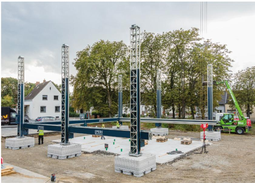
↑ Bild 8: Aufbau des COBOD BOD2 3D-Betondrucker
