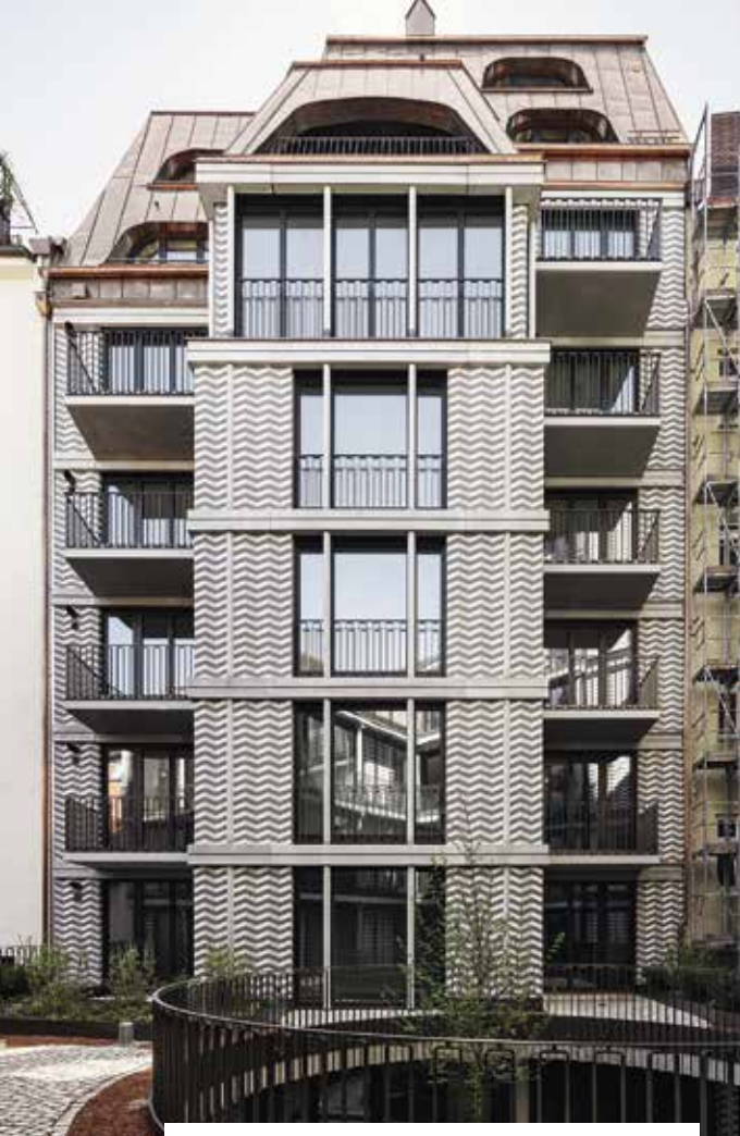
Im Innenhof ergänzt glatter Graubeton an Unterzügen und Balkondecken die gezackten Fassadenflächen.
