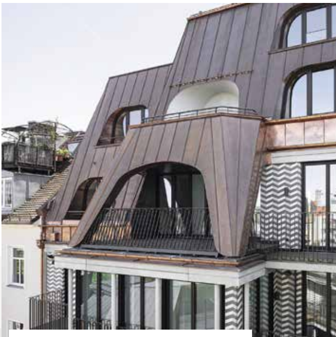
Horizontal verlaufende Gesimsbänder aus dunkelgrauem Sichtbeton und vorgelagerte, äußerst filigrane, strahlendweiße Betonstützen spielen gekonnt mit historischen Bezügen.
