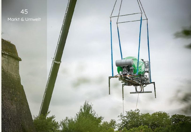
Die Betonmischtrommel schwebt über die rund 12 Meter hohe Mauer der Festung ins Innere der Anlage.
