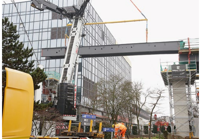
Der freischwebende Stahlträger ...
