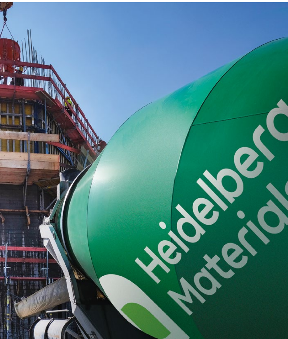
Betonanlieferung für den 18 Meter hohen Turm in R-Sichtbeton
