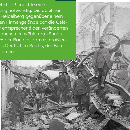
Arbeiter an der niedergebrannten Zementdampfmühle.
