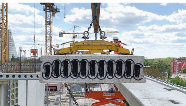
Aufgrund ihrer Hohlräume benötigen die Spannbetonhohldecken 50 Prozent weniger Beton als Ortbetondecken.
