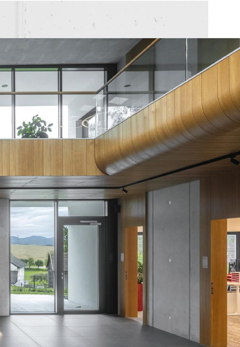
Mit Leichtbeton gestaltete Wände sind ästhetisch, wärmegeklämt, leicht und dennoch fest. Bauunternehmer Franz Alt hat dies erkannt und den Rohstoff für den Bau seines Bürogebäudes verwendet.
