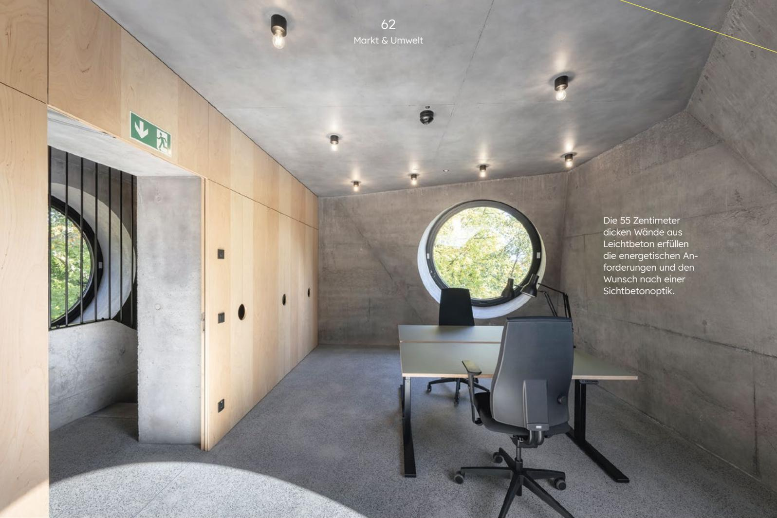
Die 55 Zentimeter dicken Wände aus Leichtbeton erfüllen die energetischen Anforderungen und den Wunsch nach einer Sichtbetonoptik.
