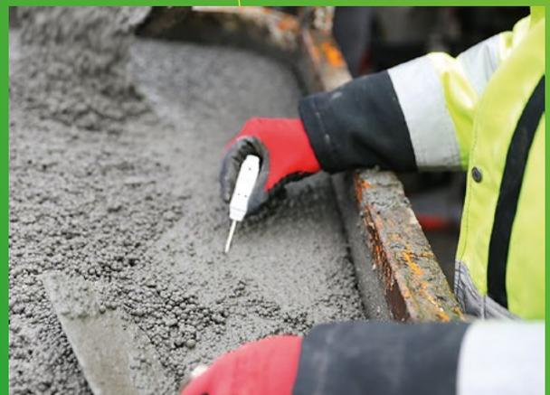
Beim Ablassen des Betons wurde die Qualität des Betons hinsichtlich Konsistenz, Frischrohddichte und Temperatur geprüft.
