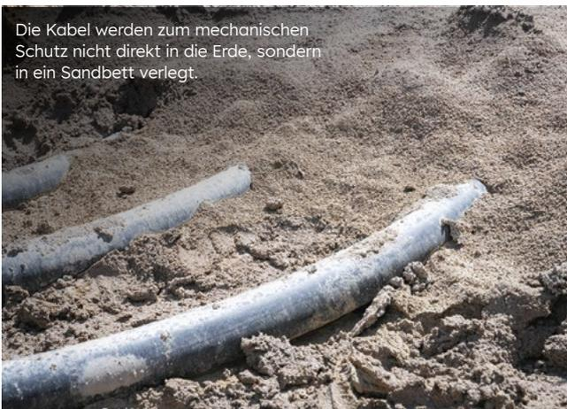
Die Kabel werden zum mechanischen Schutz nicht direkt in die Erde, sondern in ein Sandbett verlegt.
