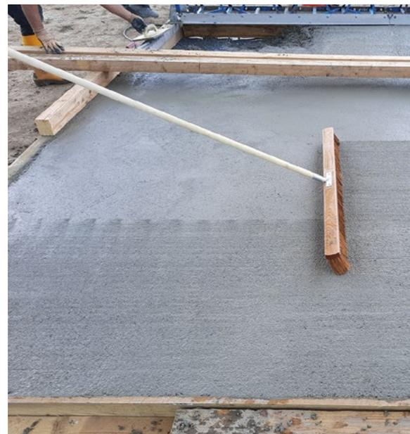
„Die Konsistenz war erst ungewohnt, da Leichtbeton steifer ist als herkömmlicher Beton. Mit einer Oberflächen-Rüttelbohle wurden die Flächen sehr schön homogen, besonders der Besenstrich hat sehr gut funktioniert.“
