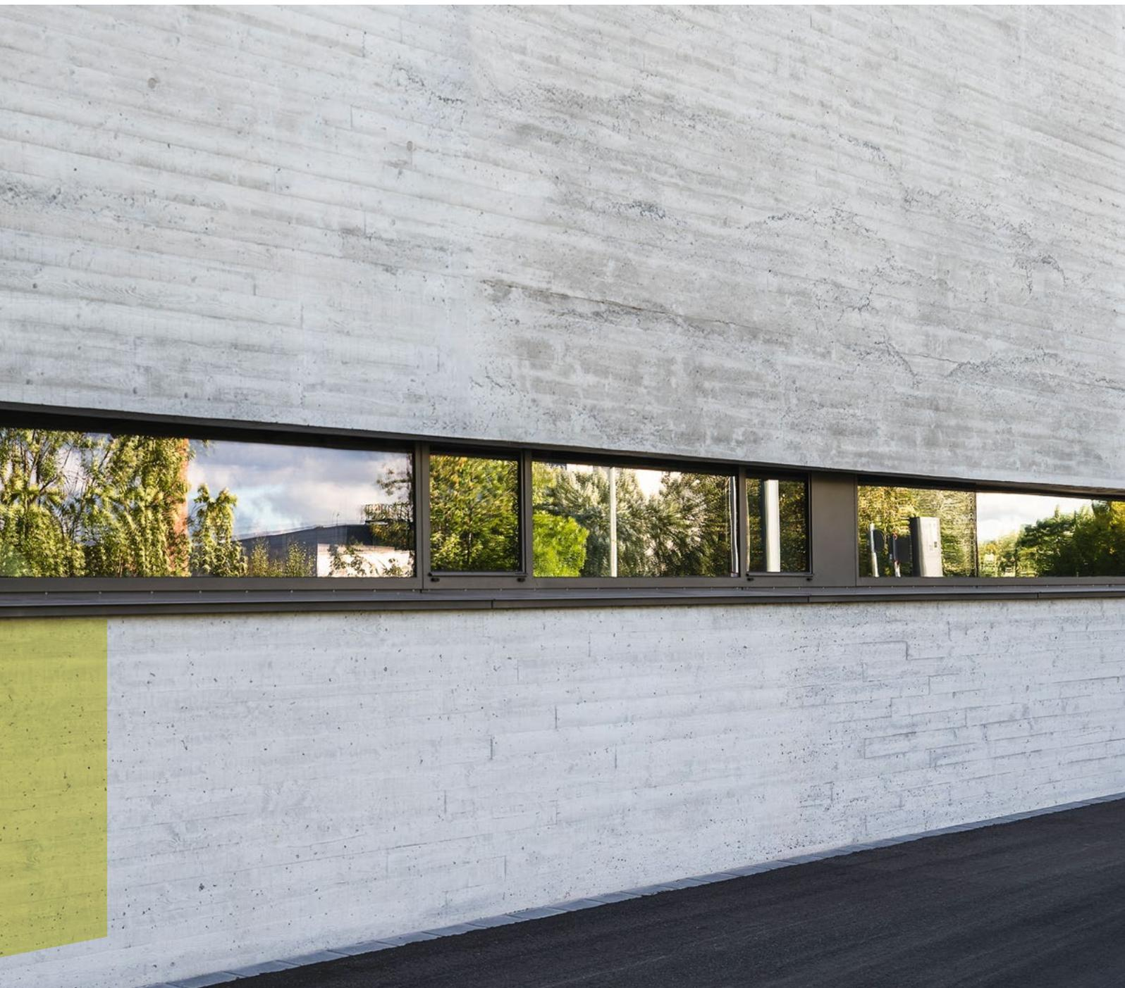
Gesteinskörnung aus Blähton und Leichtsand als Zuschläge über eine geringe Wärmeleitfähigkeit von  $\lambda \leq 0,45 \text{ W/mK}$  verfügt. Der hier verwendete Beton der Festigkeitsklasse LC12/13 gilt als leichtester, noch nach DIN EN 1992-1-1 genormter Beton. Eine geringere Rohdichte würde eine Zustimmung im Einzelfall erfordern.
