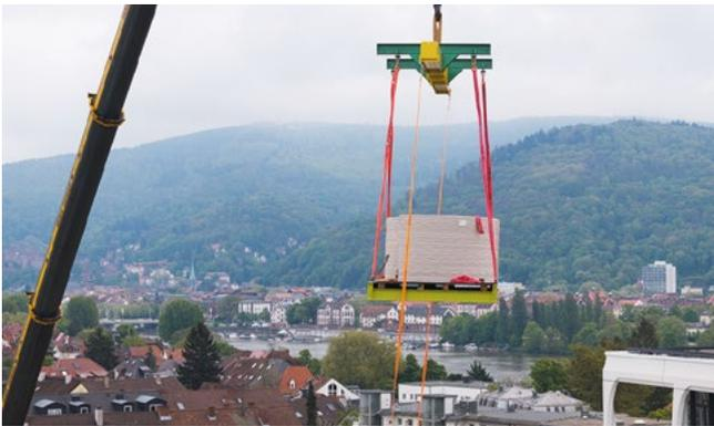
Per Autokran wurden die Freiraumelemente punktgenau zum Innenhof der Hauptzentrale gehoben.
