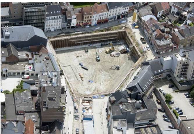
Fertige Baugrube: CSM-Wand mit eingestellter Spundwand.
