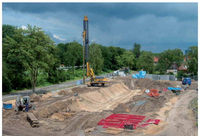
Erstellung einer CSM-Wand im freien Baufeld.
