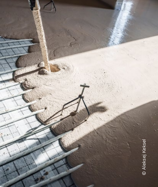
Anhyment umschließt die Heizrohre nahezu vollständig.
