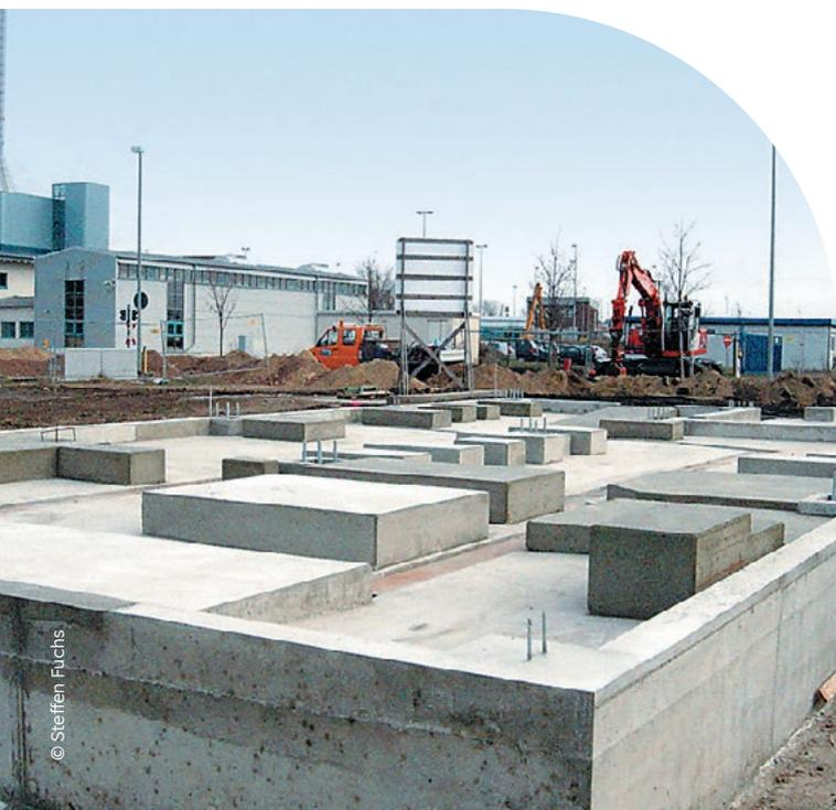
Biodieselanlage – Auffangwanne mit Fundamenten für ein Tanklager ausgeführt in Steelcrete.
