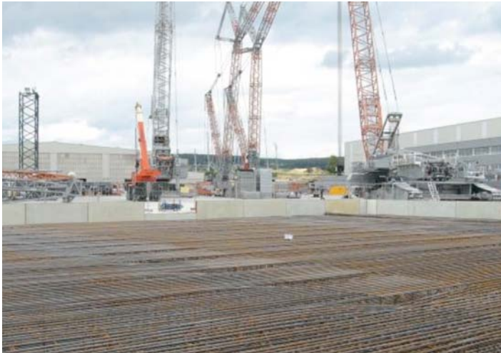
Bilder 2 und 3 : Bewehrte Bodenplatte (links) und Fühlerlage „Außen“ sowie Kabelführung von Fühlerlage „Mitte“ (rechts)
