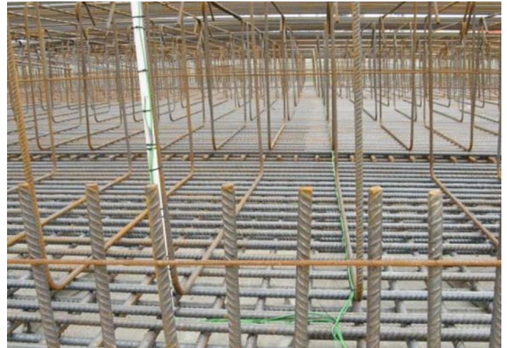
Bilder 2 und 3 : Bewehrte Bodenplatte (links) und Fühlerlage „Außen“ sowie Kabelführung von Fühlerlage „Mitte“ (rechts)
