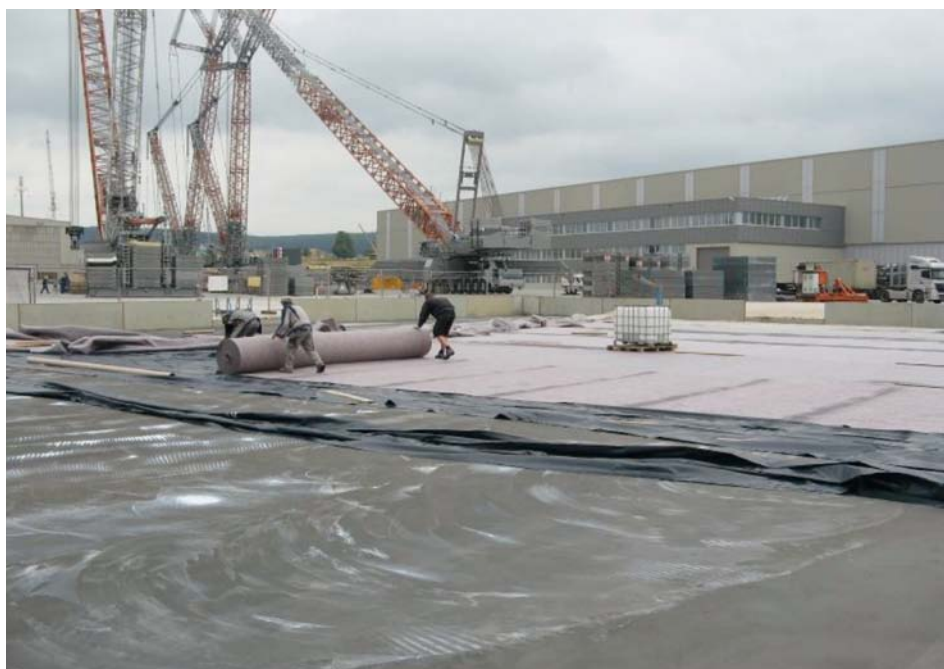
Bild 6: Nachbehandlungs- und Wärmeschutzmaßnahme
