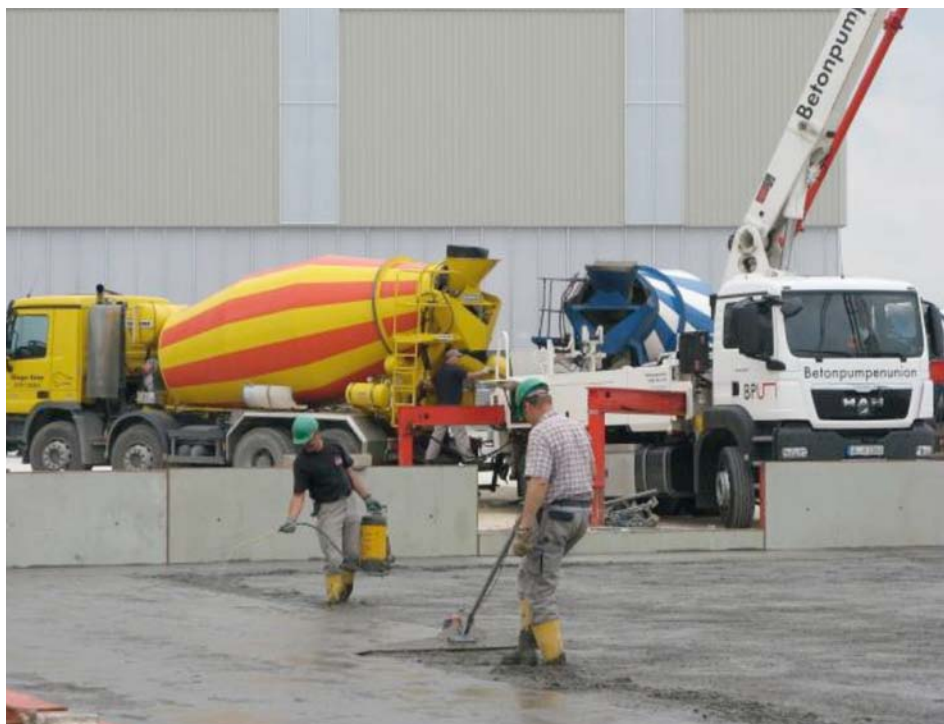
Bild 5: Nachverdichtung mit Rüttelpatsche und Auftrag Verdunstungsschutz
