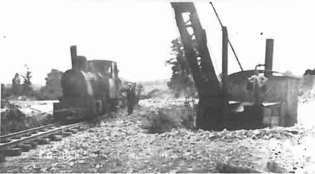
Dampfbagger und Dampflok im Steinbruch Elsa, ca. 1920
