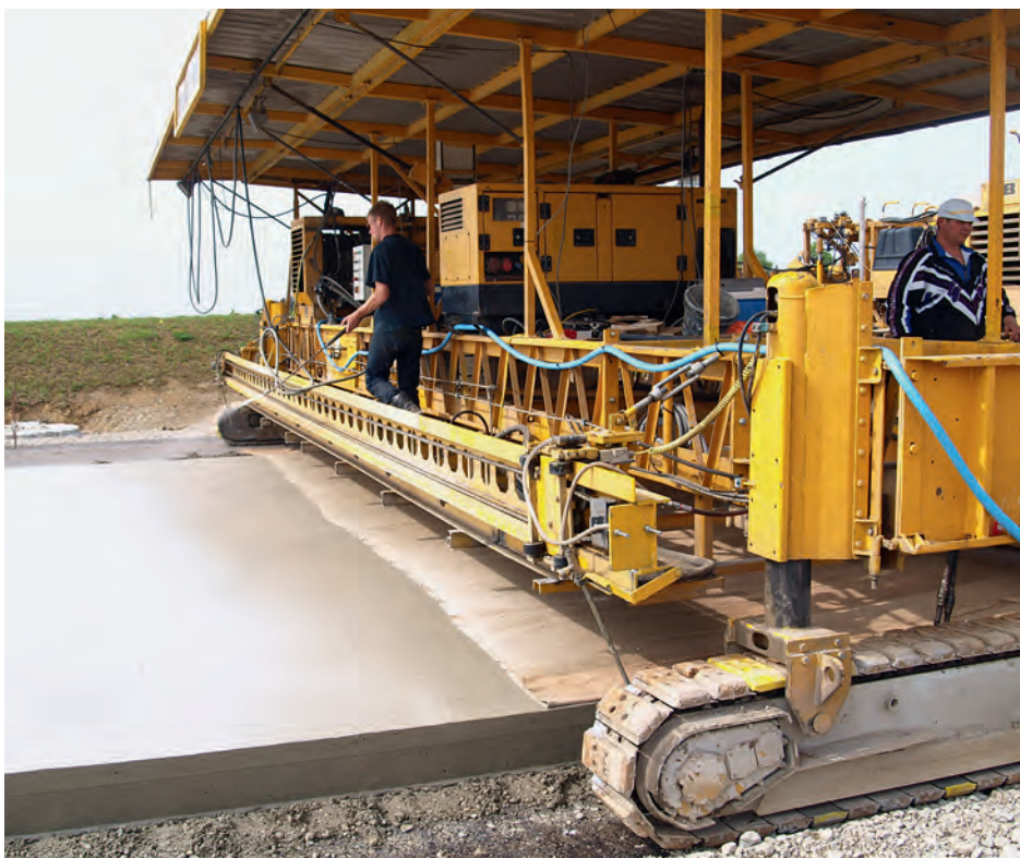
Abbildung 9: Nachbehandlung mit Curing-Mittel
