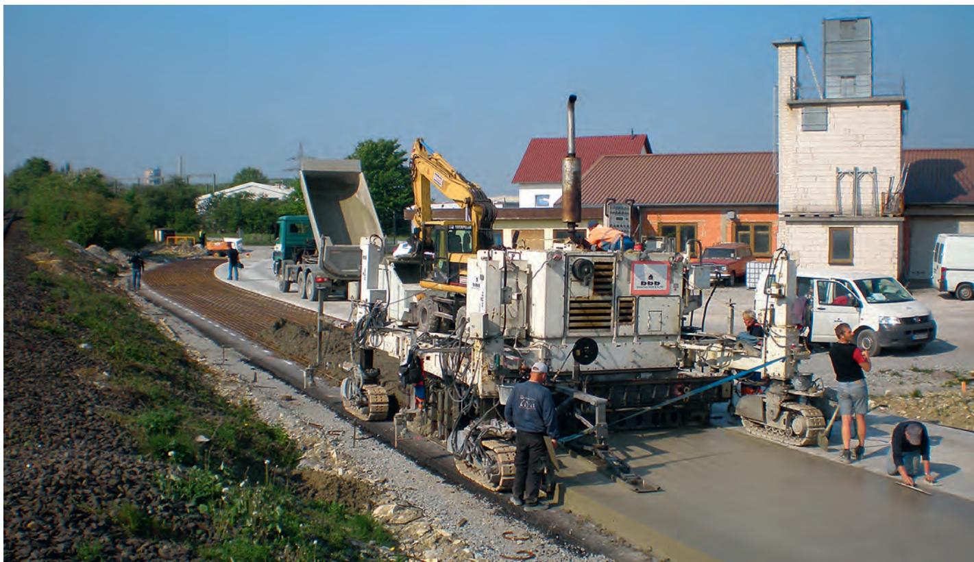
Abbildung 3: Herstellung der Betonfahrbahn mit dem Gleitschalungsfertiger
