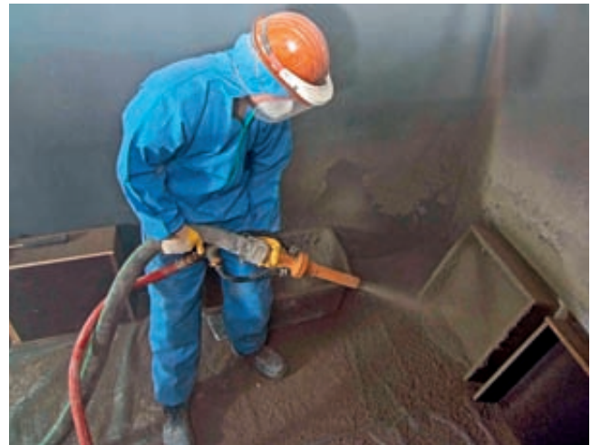
5 Spritzbetonstand zur Ermittlung der Spritzbetonfestigkeitsentwicklung
