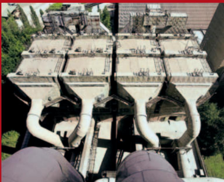
und Kalk-Gips-Basis sowie Spezialbindemittel für Umweltschutz herstellte, in Betrieb genommen. Die Anlage bestand aus einem Mischerturm und 20 Silos mit Sanden, Füllern, Bindemitteln und anderen Komponenten. Über einen Leitstand wurden die unterschiedlichen Materialien über pneumatische Fördersysteme dem Mischerturm zugeführt und unter diesem direkt in Fahrzeuge verladen. Mit der Inbetriebnahme des Trockenmörtelwerks war die Steigerung der Gipsqualität eine ständige Aufgabe.<sup>206</sup>
