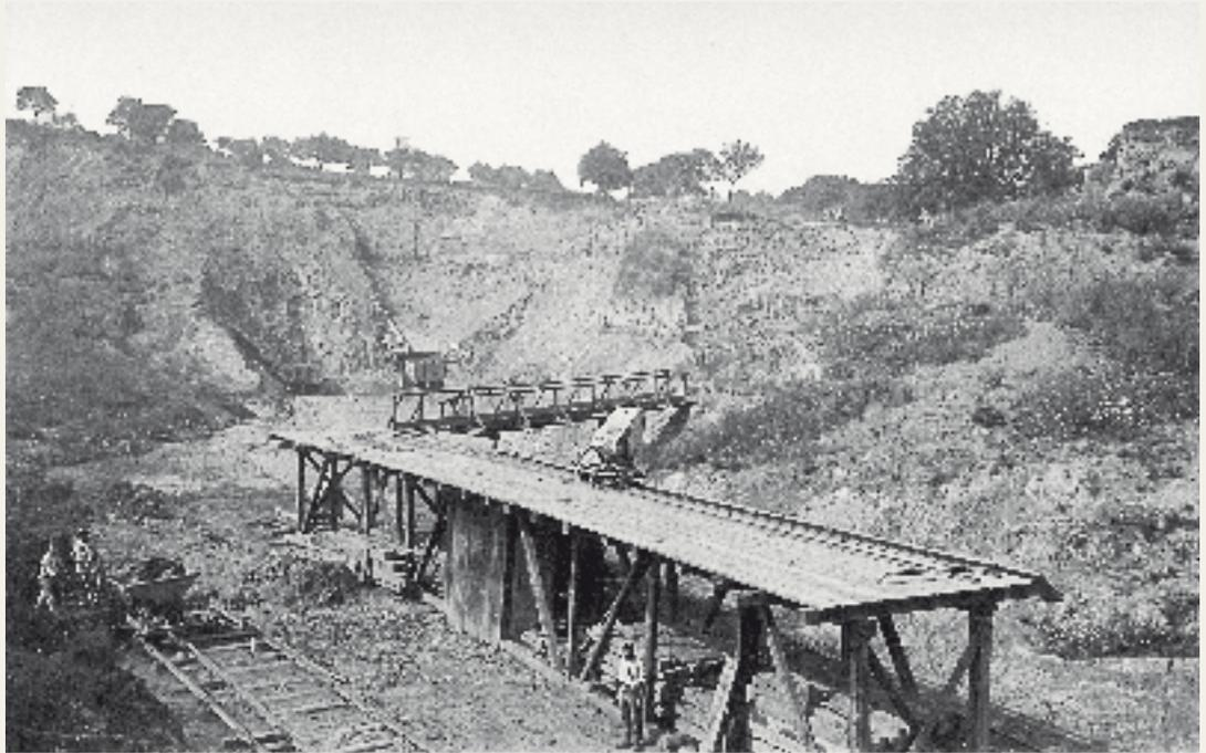
**HANDABBAU IM STEINBRUCH** und Verladung auf offene Waggons mittels Verladerampen, 1893.
