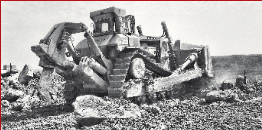
Die Lockerung des Kalksteinmergels mit REISSRAUPEN (Caterpillar D9 und Fiat-Allis HD41), reduzierte die Anzahl der Sprengungen und damit die Sprengerschüttungen für die umliegenden Siedlungen erheblich, ca. 1970.
