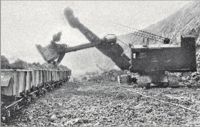
MENCK-ELEKTROBAGGER mit 750 m Kabel,
