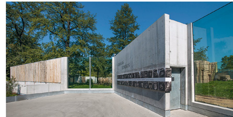
Auch die Umfriedung der Außenanlage für die Gorillas wurde teilweise in Sichtbeton ausgeführt. Der Beton wechselt sich mit Holzbretterwänden und großen Glasflächen ab. So setzt sich die Materialität des Hauptbaus außen fort.
