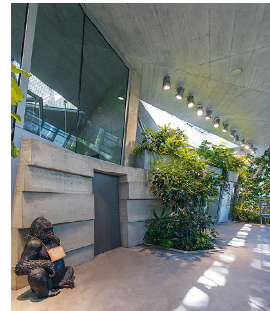
Im Inneren des „Affenberges“, der neuen Anlage für Afrikanische Menschenaffen in Stuttgart, dominiert Sichtbeton die Gestaltung. Der Beton der Gehege wurde wegen der erhöhten Belastung in der Expositionsklasse XC3 beziehungsweise XA1 ausgeführt.
