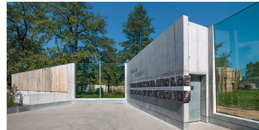
Auch die Umfriedung der Außenanlage für die Gorillas wurde teilweise in Sichtbeton ausgeführt. Der Beton wechselt sich mit Holzbretterwänden und großen Glasflächen ab. So setzt sich die Materialität des Hauptbaus außen fort.
