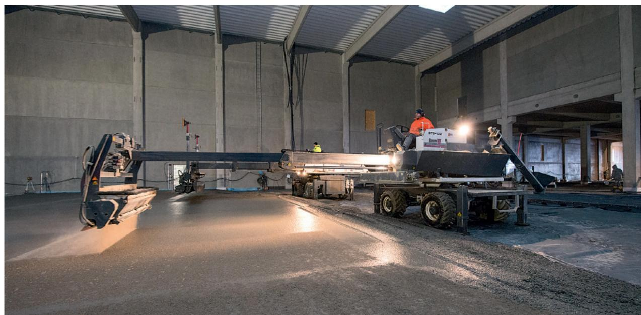
In den riesigen Hallen bringen Spezialmaschinen den Betonboden ein.
