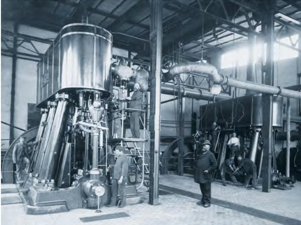
Kuhnsche Dampfmaschine im Maschinenhaus Block II.
