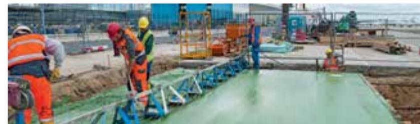
Nach dem Verfüllen mittels Betonpumpen und dem Abziehen der Betonfläche entsteht ein sauber abgegrenzter Bereich mit einer nicht für Abrieb anfälligen Färbung.
