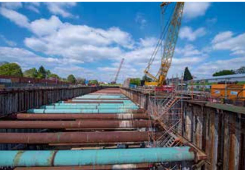
Die Spundwände wurden bei der Erstellung in bis zu drei Ebenen mit Gurten und Rohren ausgesteift.
