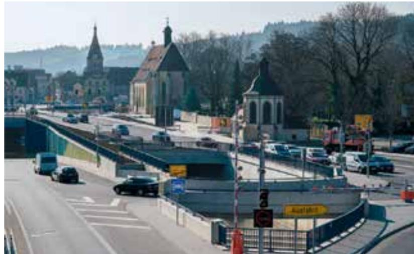
Im Einfahrtbereich des neuen Einhorn-Tunnels in Schwäbisch Gmünd wurden 3.350 Quadratmeter des Pflasters Tetrago Airsave der Firma Godelmann verlegt – hergestellt mit dem Spezialzement TioCem von HeidelbergCement.
