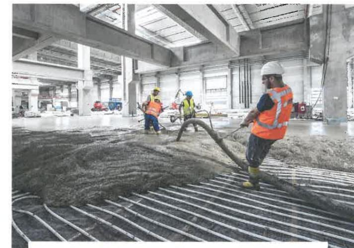
Wegen der empfindlichen Heizschlangen konnte die Fläche nicht mit dem Mischer befahren werden. Steelcrete wurde mit einer Betonpumpe jeweils an Ort und Stelle gefördert und dort verteilt.
