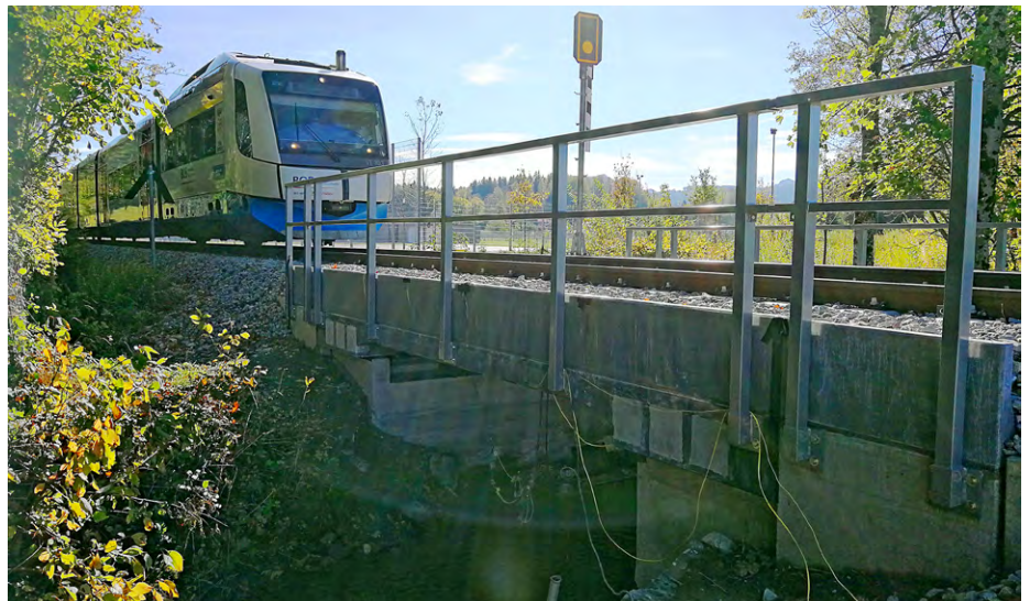
↑ Abbildung 6: Eisenbahnbrücke mit Messtechnik in Betrieb (© Prof. Fischer, TU München)
