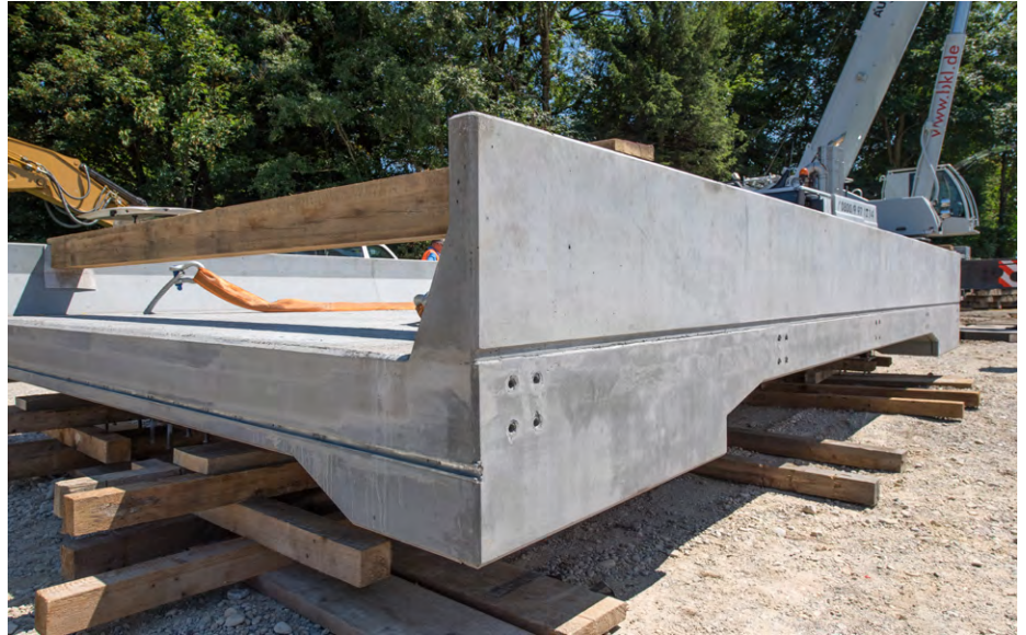
↑ Abbildung 1: Querschnitt der Eisenbahnbrücke mit Schotterhalterung
