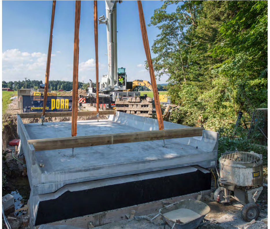
↑ Abbildung 5: Auf bestehende Widerlager aufgelegte Fertigteilbrücke
