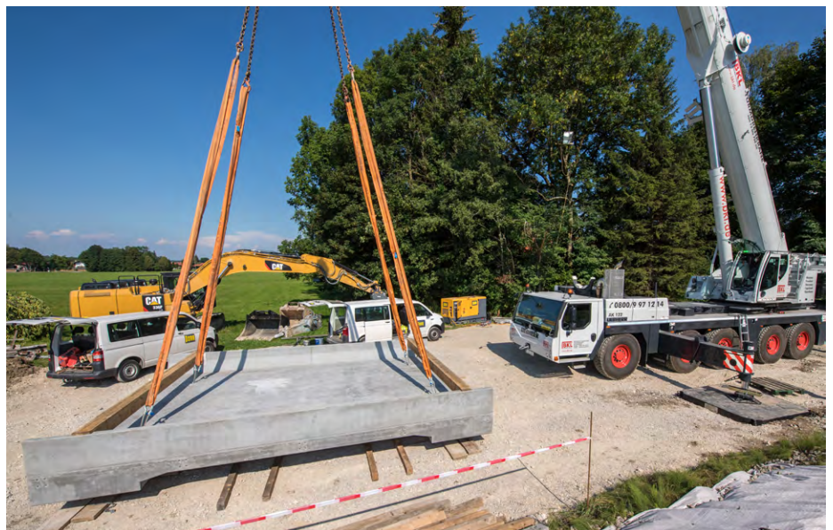
↑ Abbildung 4: Einheben des Fertigteils mithilfe eines Autokrans
