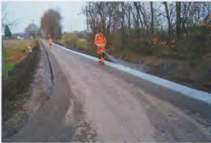
Bild 6: Nachbehandlung des eingebauten Bankettbetons
