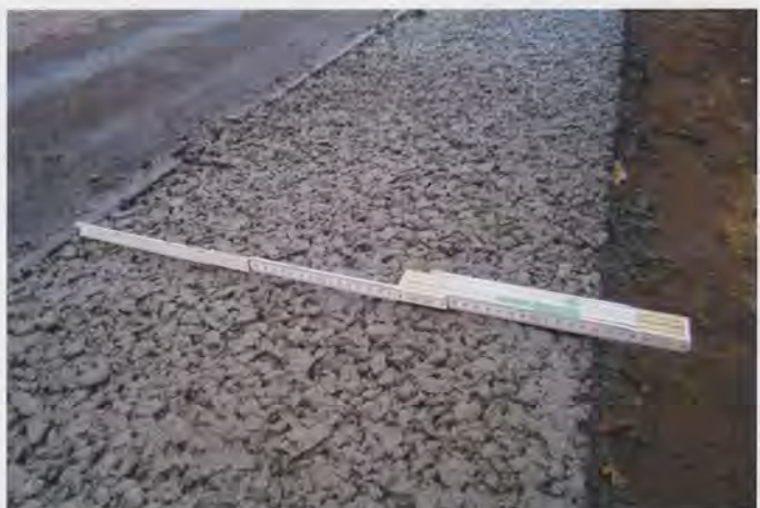
Bild 5: Fertiger Bankett-Einbaustreifen
