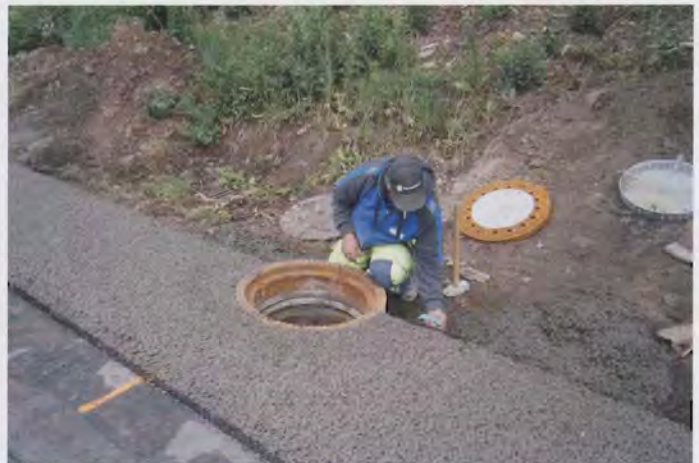
Bild 11: Fertig eingebaute Schacht
