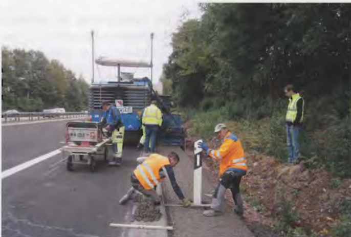
Bild 10: Einbau Leitpfosten
