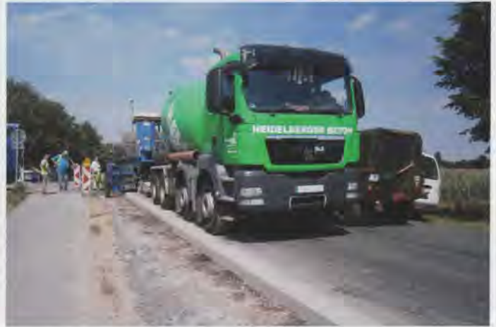
Bild 14: Bankettbetoneinbau mit Offset-Gleitschalungsfertiger
