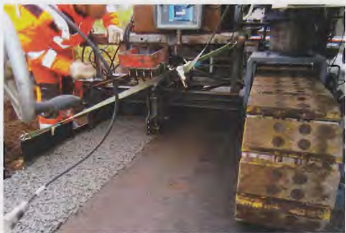
Bild 4: Fertiger Bankettstreifen hinter dem Offset-Gleitschalungsfertiger
