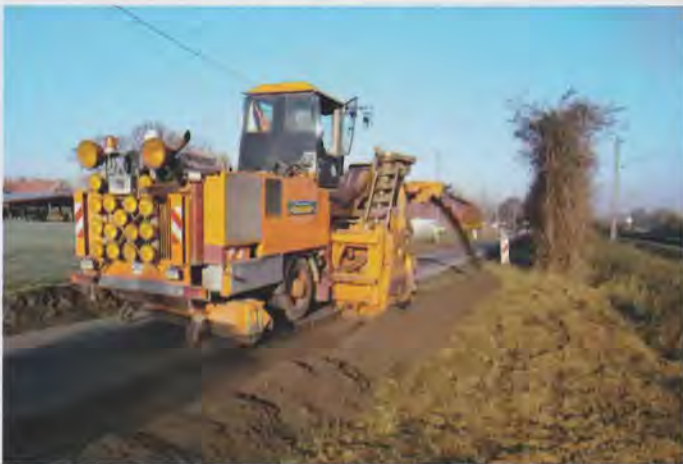
Bild 2: Ausbau des vorhandenen Banketts mit der Bankettfräse
