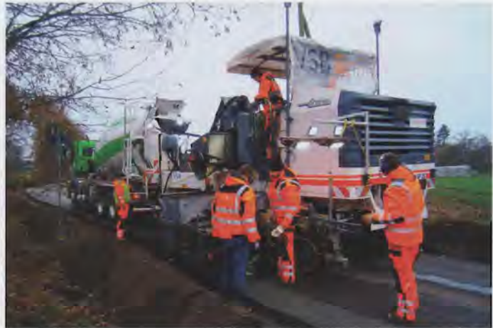
Bild 3: Bankettbetoneinbau mit dem Offset-Gleitschalungsfertiger
