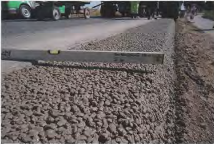
Bild 13: Detail: Bankettbetonquerschnitt
