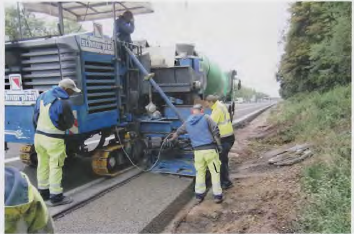
Bild 9: Fertiger Bankettstreifen hinter Einbaumulde
