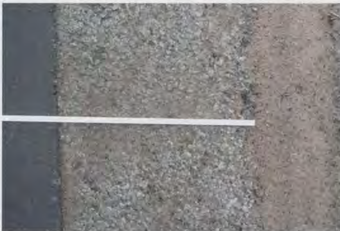
Bild 7: Hinterfüller und mit Erdreich angegedeckter Bankettbeton
