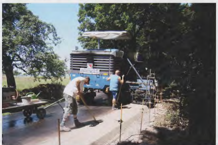
Bild 12: Fertiger Bankettbetonstreifen
