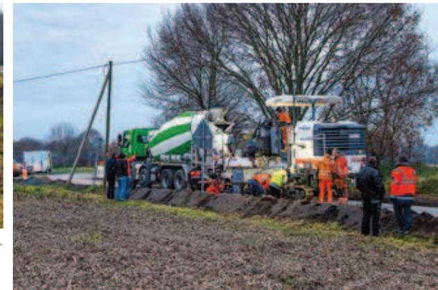
Der Beton wurde von der Firma VSB infra GmbH & Co. KG, Dortmund bei kühler Witterung (Lufttemperatur 6 bis 9 Grad Celsius / Betontemperatur 12 bis 14 Grad Celsius) mit dem Gleitschalungsfertiger eingebaut. Die durchschnittliche Einbaugeschwindigkeit lag bei 1,7 Metern pro Minute, so dass der Einbau in einer Tagesleistung erfolgen konnte.
