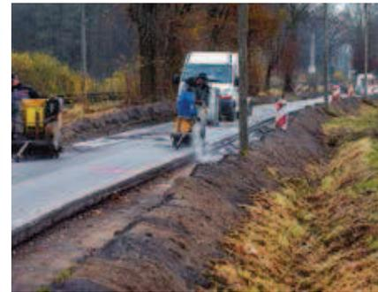
Die teilweise stark ausgebrochenen Fahrbahn­ränder der Asphaltbefestigung wurden mit einem circa fünf Zentimeter breiten Tiefschnitt begradigt, so dass zwischen dem Bestand und dem neuen Bankettbeton eine saubere Pressfuge hergestellt werden konnte. Mit einer Bankettfräse wurden die ungebundenen Bankette in einer Breite von circa 100 Zentimeter und 23 Zentimeter Tiefe gefräst.
