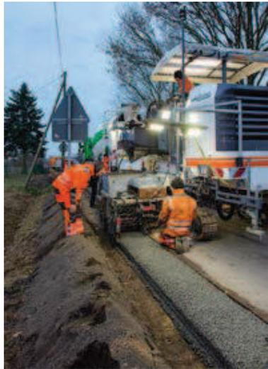
Banketteinbau mit dem Offset-Gleitschalungsfertiger
