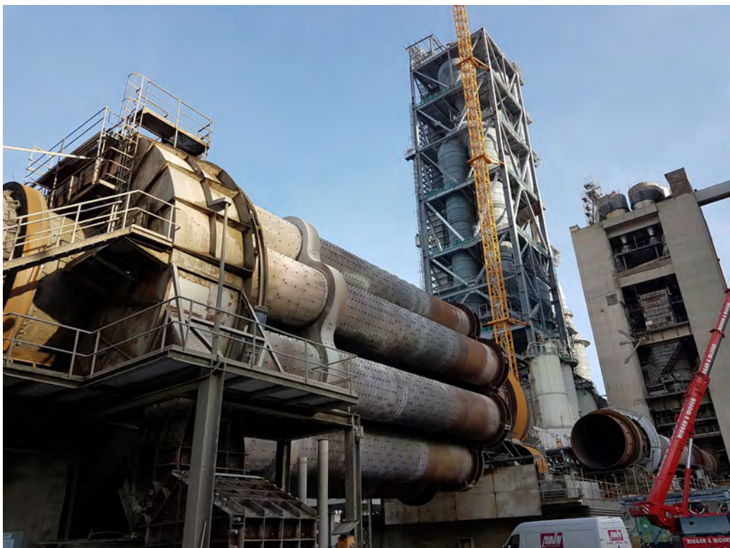
← Abb. 3: Der alte Satellitenkühler vor dem neuen Zyklonwärmetauscher in Schelklingen
