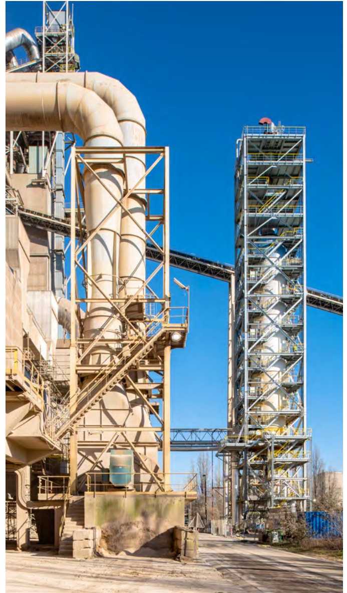
↑ Abb. 2: Der neue DSR-Reaktor optimiert den Kalzinierungsprozess im 60 Meter hohen Vorwärmerturm im Werk Lixhe.
