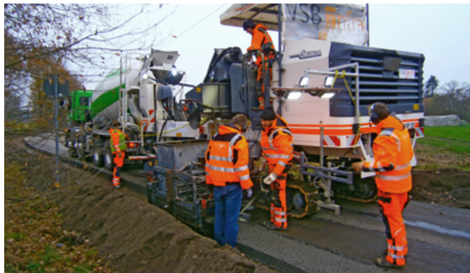
↑ Bild 3: Bankettbetoneinbau mit dem Offset-Gleitschalungsfertiger
