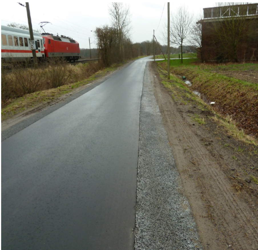
↑ Bild 8: Fertige Straße unter Betrieb
