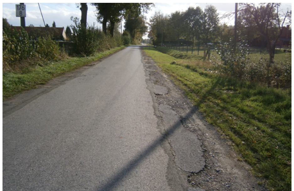
↑ Bild 1: Zustand der Bankette „An der Schlippe“ vor der Instandsetzung
