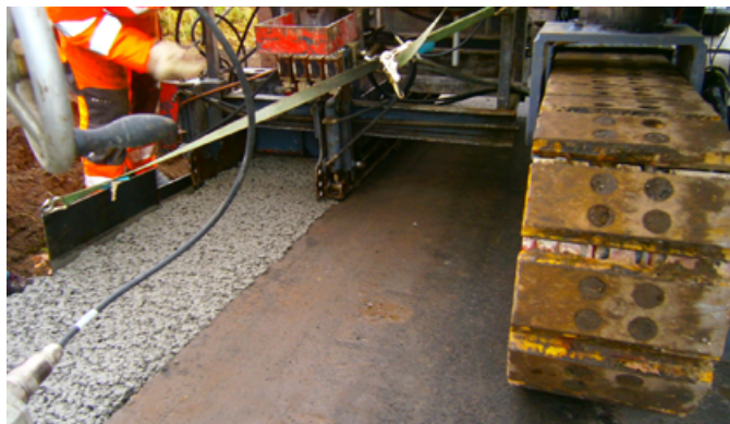
↑ Bild 4: Bankettstreifen hinter dem Offset-Gleitschalungsfertiger
