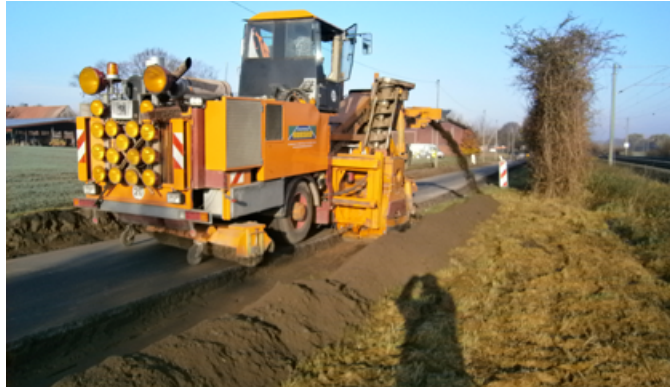
↑ Bild 2: Ausbau des vorhandenen Banketts mit der Bankettfräse
