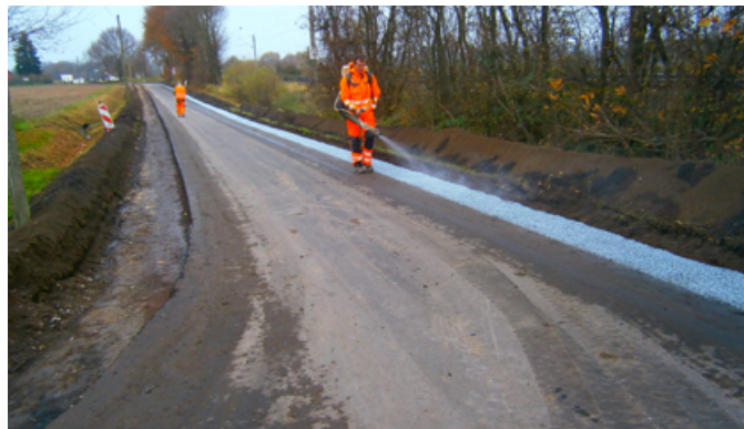
↑ Bild 6: Nachbehandlung des eingebauten Bankettbetons
