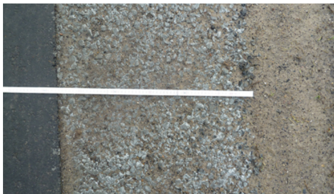
↑ Bild 7: Hinterfüllter und mit Erdrich angedeckter Bankettbeton
