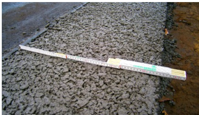
↑ Bild 5: Fertiger Bankett-Einbaustreifen
