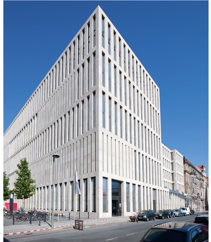
↑ Leichtbetonbauweise bei der Zentralbibliothek Humboldt Universität, Berlin. Architekt Max Dudler
