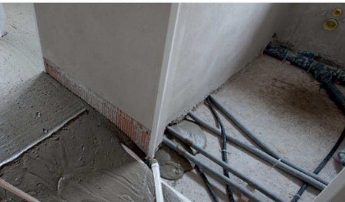
← Sichere Einbettung von Rohren, Leitungen und Kanälen.
