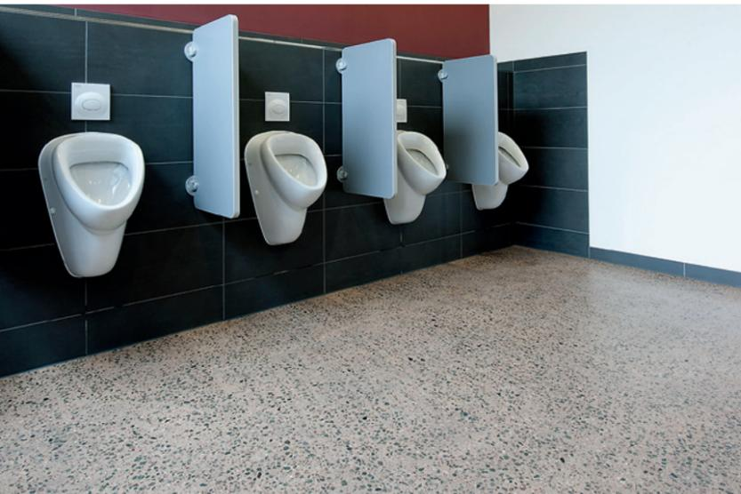
bereits einen polierten Industrieestrich konzipiert. In den Hallenbauten des zweiten Bauvorhabens sollte nun eine massive Bodenplatte geschaffen werden, deren Oberfläche terrazzoartig das Gefüge der Bestandteile des Betons zeigt.
