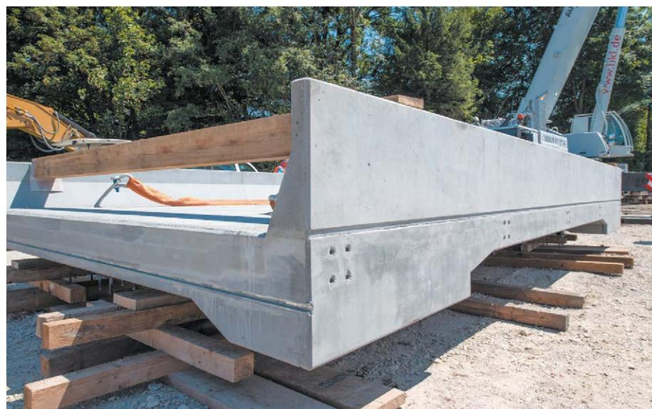
Bild 1: Querschnitt der Eisenbahnbrücke mit Schotterhalterung
