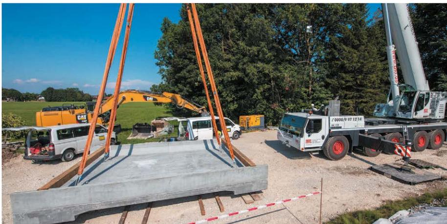
**Bild 4: Einheben des Fertigteils mithilfe eines Autokrans**
