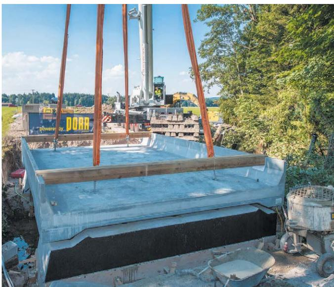
**Bild 5: Auf bestehende Widerlager aufgelegte Fertigteilbrücke**
