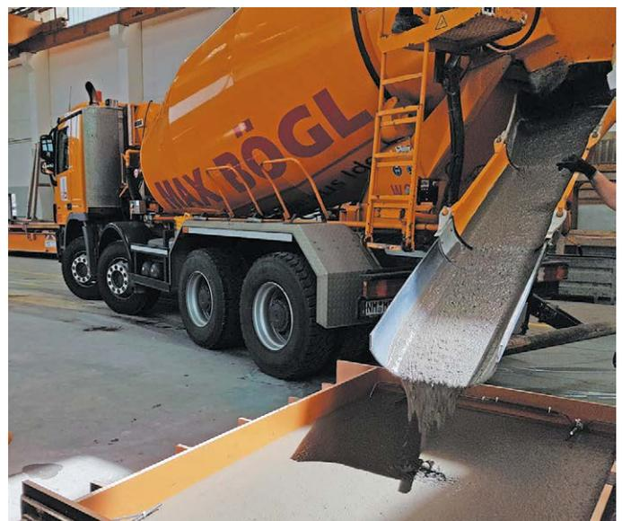
Bild 3: Probetonage im Fertigteilwerk
