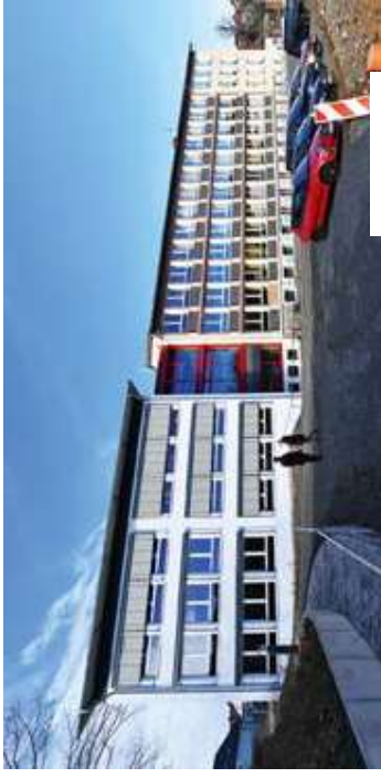
Zwischen dem neuen Klassen- trakt und dem Bestand vermittelt eine weitgehend verglaste Fuge.
