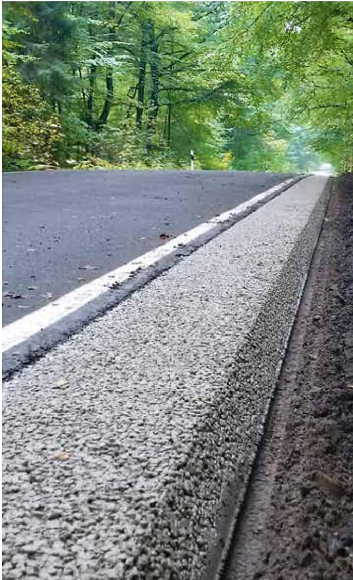
← Fertiger Bankettbetonstreifen, L208 im Streckenabschnitt Aumühle-Kuddewörde bei Hamburg
