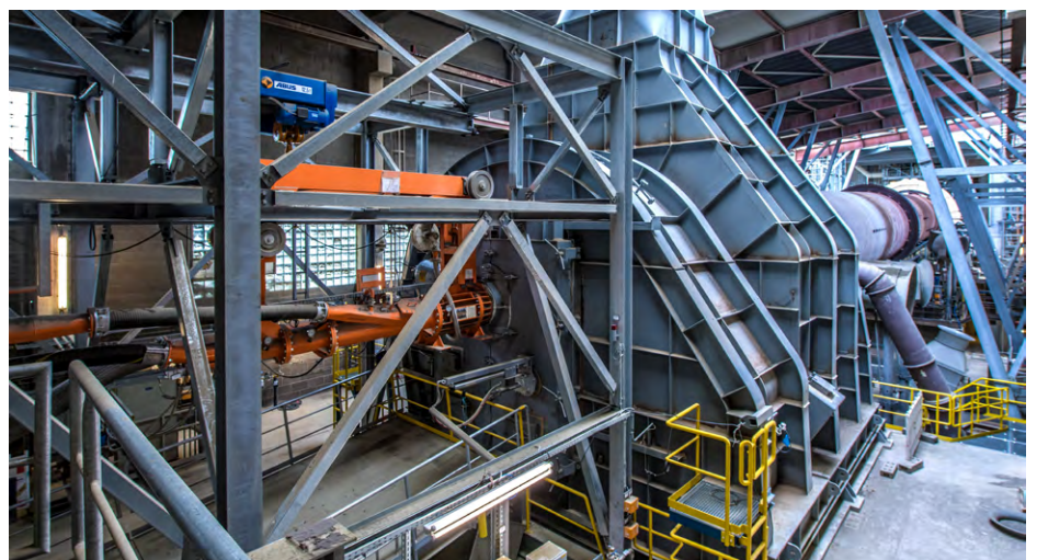
↑ Abbildung 3: Blick auf den neuen Ofen
