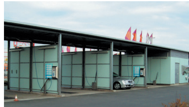
↑ Fahrzeugwaschplätze ausgeführt in Steelcrete.
