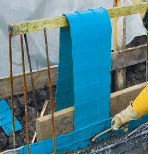
Bild 26: Dichte Bauwerke – ← Einbau des Fugenbandes
