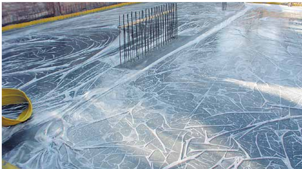
Bild 36: Nachbehandlung im Sommer: → Schutz u. a. vor dem Austrocknen
