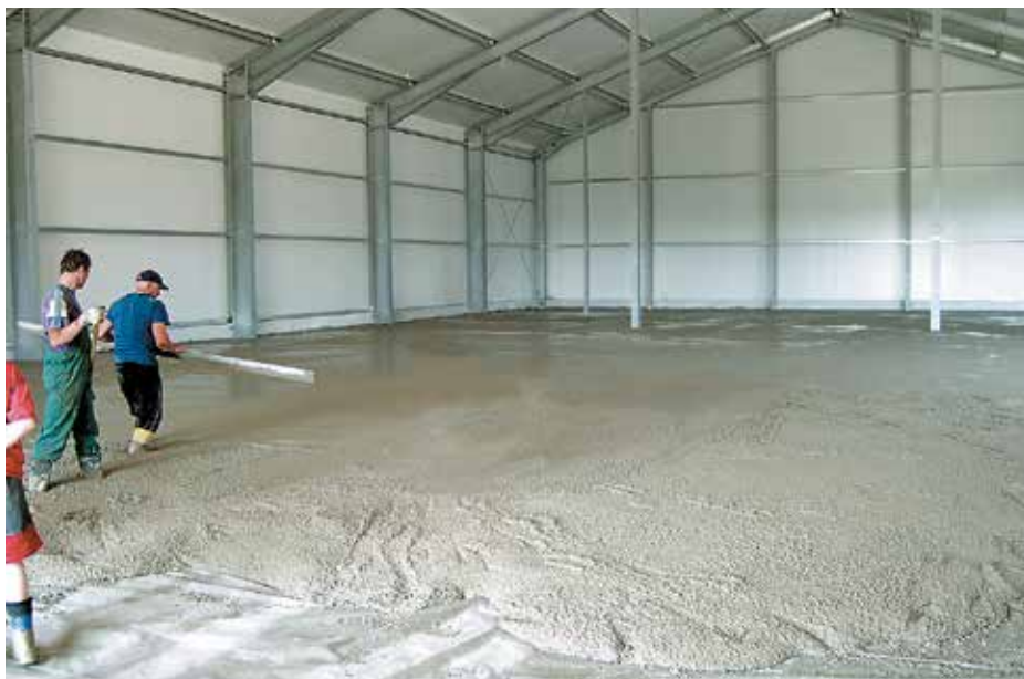
↑ Bild 34: Einbau von Stahlfaserbeton: Industrieböden
