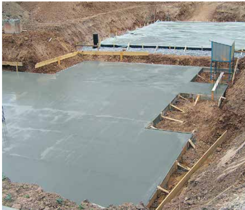
↑ Bild 16: Stahlfaserbetonbodenplatte im Wohnungsbau
