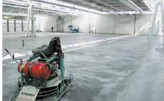
↑ Bild 10: Glätten des Industriebodens
