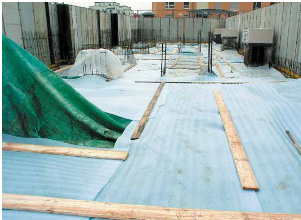
Bild 39: Nachbehandlung im Winter: → Schutz u. a. vor dem Auskühlen
