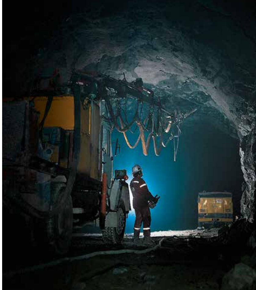
↑ Bild 19: Stahlfaserspritzbetonauftrag im Tunnel
