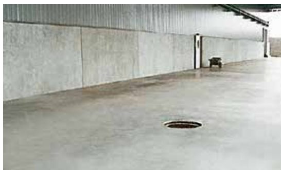
↑ Bild 12: Freifläche aus Stahlfaserbeton
