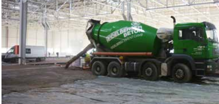
↑ Bild 9: Herstellung Industrieboden
