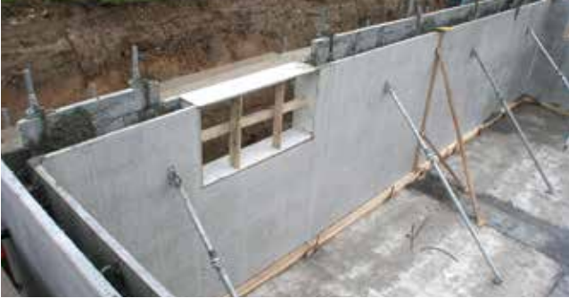
↑ Bild 14: Kellerwände aus Halbfertigteilen (mind. 30 cm Wandstärke)
