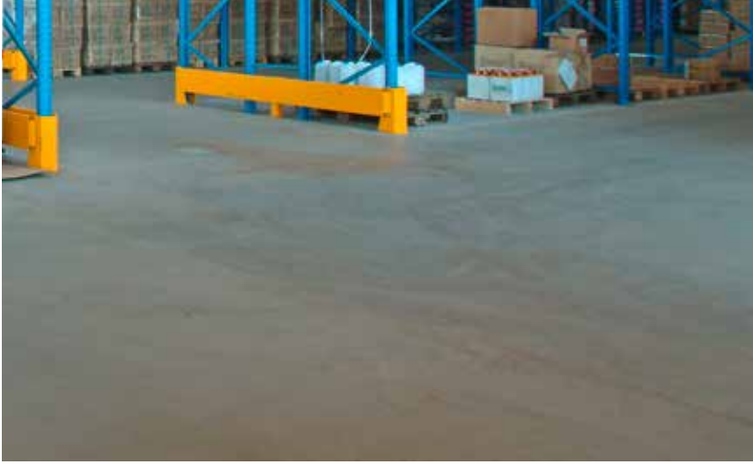
↑ Bild 11: Fugenloser Industrieboden
