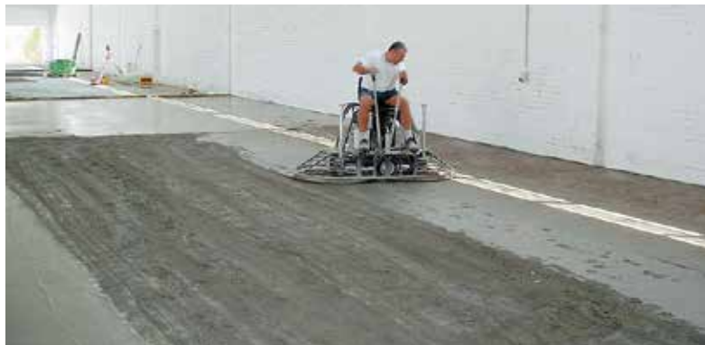
↑ Bild 37: Glätten eines Industriebodens mit Flügelglätter
