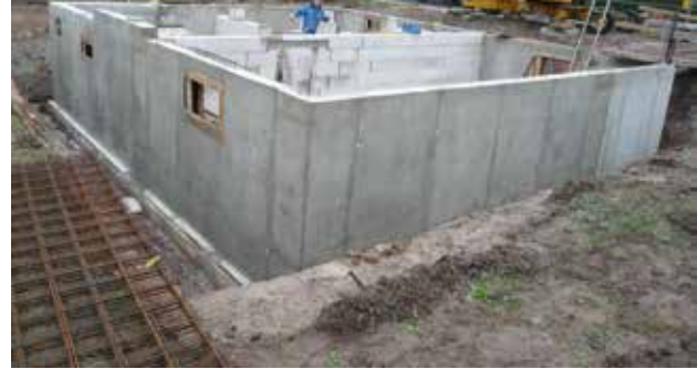
↑ Bild 15: Fertiger Keller aus Stahlfaserbeton
