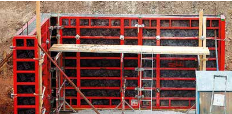
↑ Bild 17: Einbau des Stahlfaserbetons in eine Kellerwandschalung
