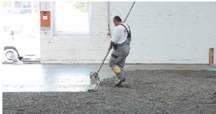
↑ Bild 38: Glätten eines Industriebodens mit Rüttelpatsche
