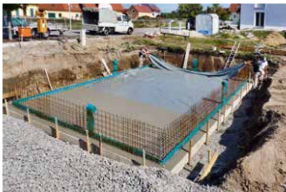
↑ Bild 27: Fertig betonierte Bodenplatte mit vorbereiteten Fugenbändern
