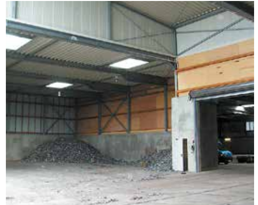
↑ Bild 22: Biomüllkompostanlage – Bodenplatte und Wände ausgeführt in Steelcrete
