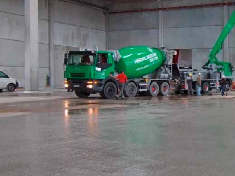
↑ Bild 35: Betonage eines Industriebodens
