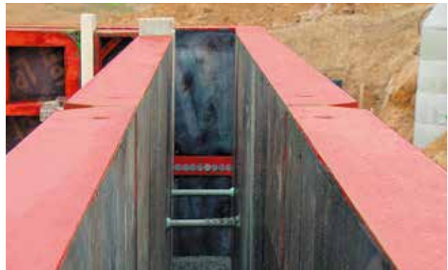
↑ Bild 18: Geschalte Kellerwand für Stahlfaserbeton
