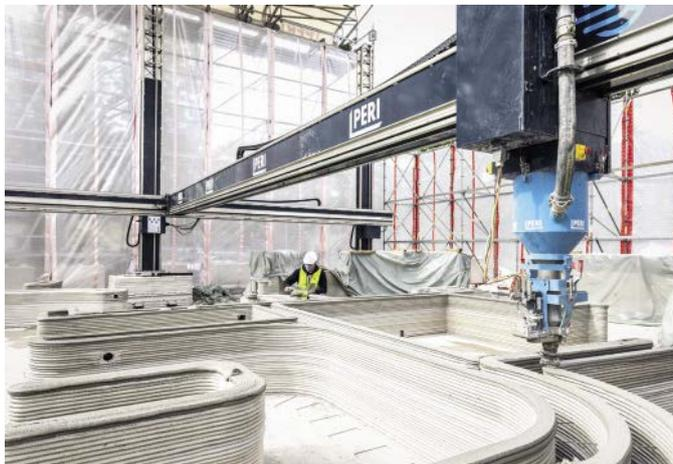
Bild 1: Druckprozess mit dem BOD2
