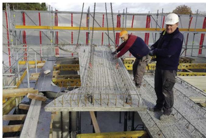
Bild 5: Bauprozess mit eingehängter Decke
