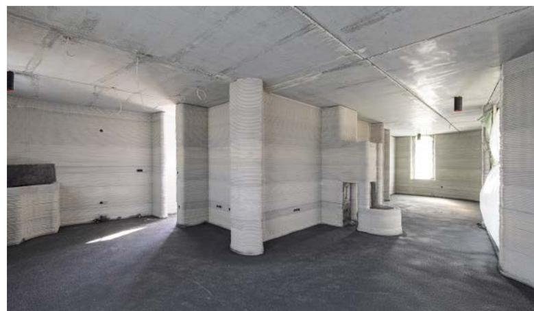
**Bild 9: Erdgeschoss mit Kamin des 3D-gedruckten Hauses in Beckum**
