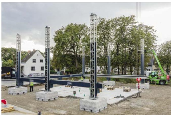
**Bild 8: Aufbau des COBOD BOD2 3D-Betondruckers**
