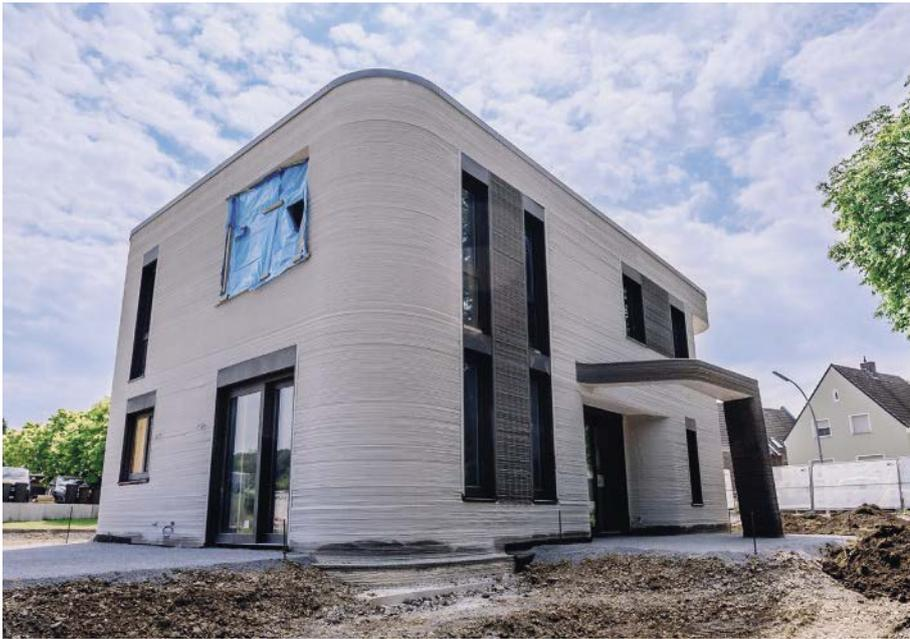
**Bild 10: Außenansicht des ersten 3D-gedruckten Gebäudes in Beckum kurz vor Fertigstellung**
