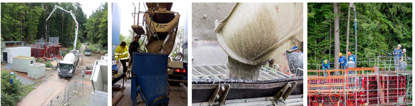
↑ Bild 13: Einbau mit der Betonpumpe und dem Betonkübel
