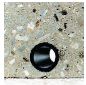
Querschnitt: Fließestrich auf Fußbodenheizung ↑
