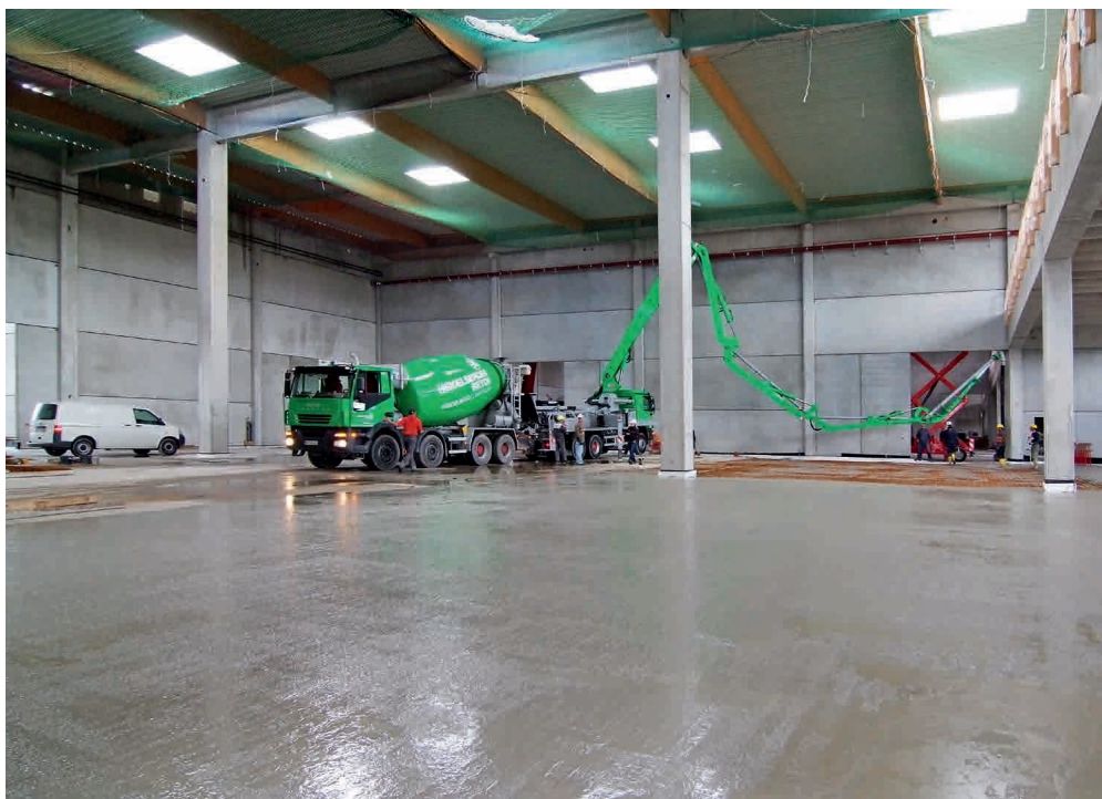
Einbau mittels Betonpumpen
