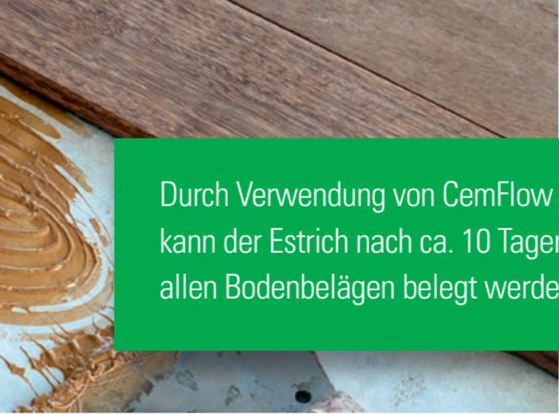
Durch Verwendung von CemFlow TOP kann der Estrich nach ca. 10 Tagen\* mit allen Bodenbelägen belegt werden.
