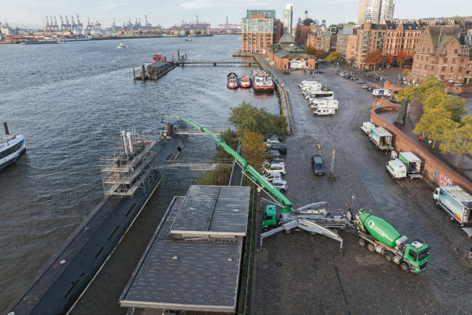
vor Korrosion bewahrt. Mit seiner fließfähigen Konsistenz und hoher Pumpfähigkeit lässt sich der Unterwasserbeton mühelos einbauen – ganz ohne zusätzliche Verdichtung“, ergänzt Vladimir Prudovskiy, Prüfstellenleiter Heidelberg Materials Beton, Region Nord-West.
