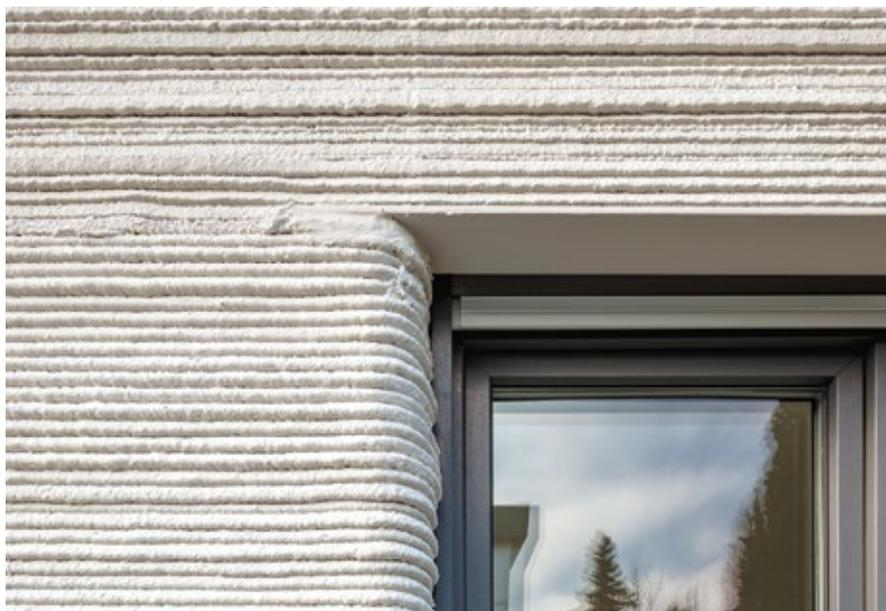
**D**er bei diesem Bauvorhaben verwendete evoBuild 3D-Druck von Heidelberg Materials ist ein Hightech-Baustoff, der zu 100 Prozent recycelbar ist und ein Bindemittel mit einer CO<sub>2</sub>-Reduktion von etwa 55 Prozent im Vergleich zum Portlandzement beinhaltet. Die additive Fertigung ermöglichte eine erhebliche Zeitersparnis, da die reine Druckzeit für das gesamte Gebäude lediglich 118 Stunden betrug.
