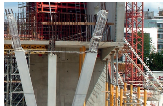
Bild 14: Geschützte Anschlussbewehrung
