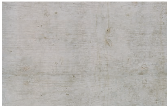
Bild 5b: 3-Schichtplatte Schalung Abbild
