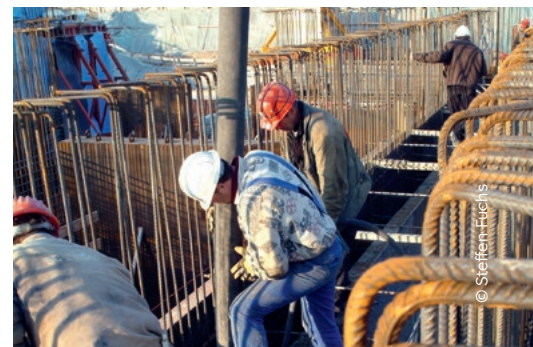
Bild 15: Wandbetonage mit Betonpumpe
