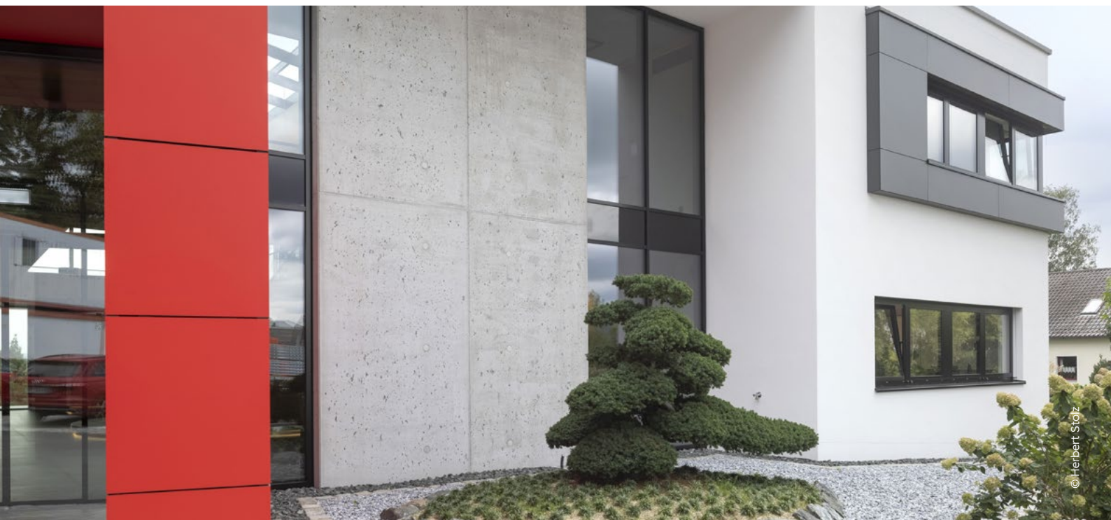
Bild 12: Bürogebäude der Alt Bau GmbH in Pemfling, Bayern
