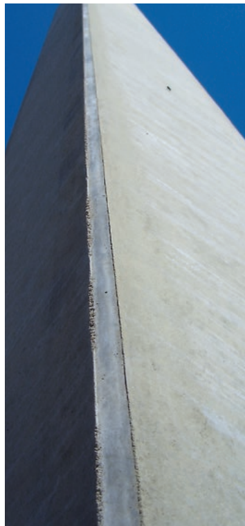
Bild 5c: Ergebnis mit gebrochener Kante
