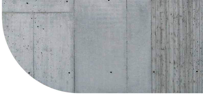
Bild 7: Einfluss der Schalung auf die Optik der Sichtbeton-Oberfläche, bei gleichzeitiger Betonage aus einer Lieferung.
