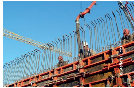
Bild 13: Bewehrung eines Bauteils
