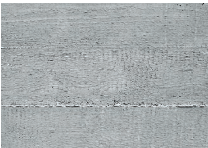
Bild 8a: Bretter sägerau, saugend, texturiert
