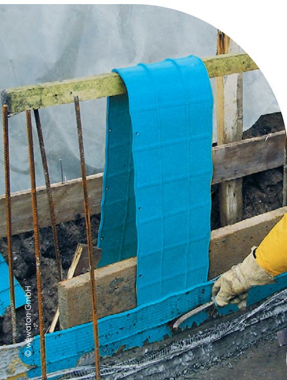
Bild 27: Dichte Bauwerke – Einbau des Fugenbandes
