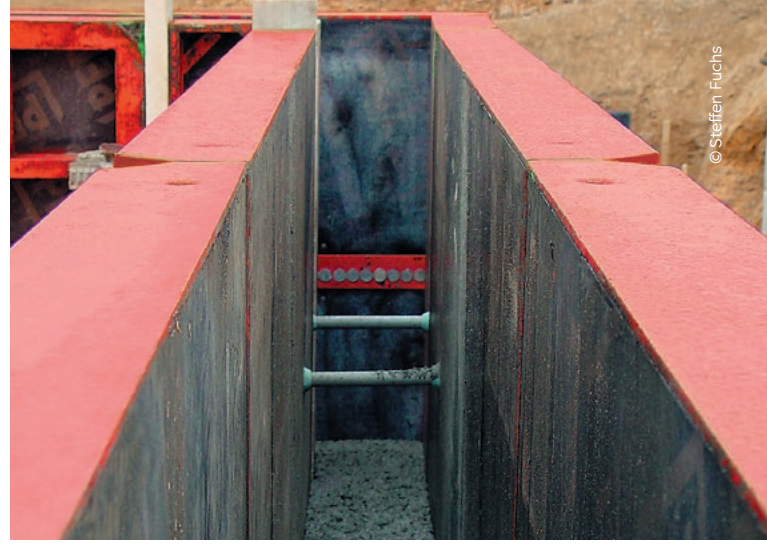
Bild 19: Geschaltete Kellerwand für Stahlfaserbeton
