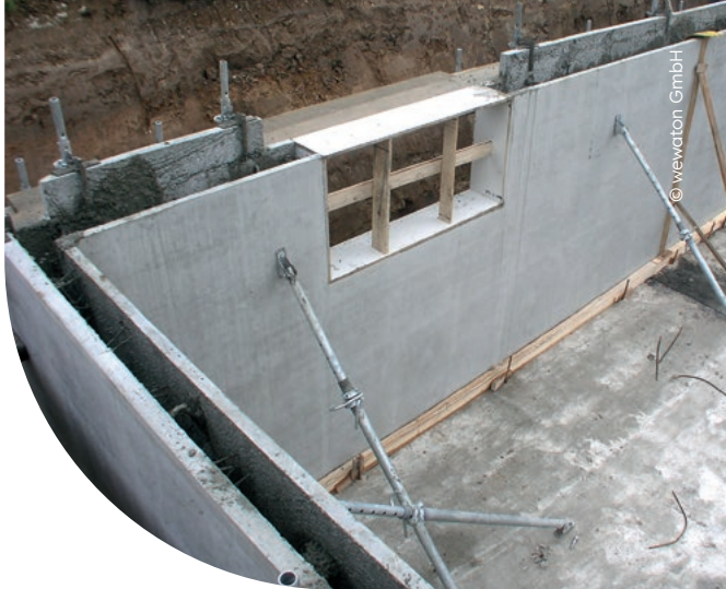
Bild 15: Kellerwände aus Halbfertigteilen (mind. 30 cm Wandstärke)
