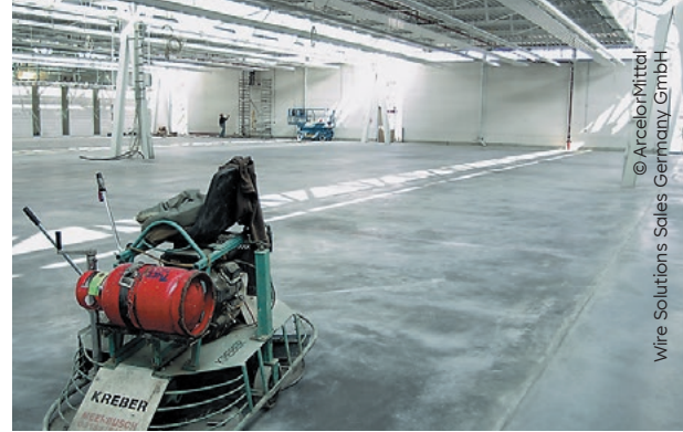
Bild 11: Glätten des Industriebodens
