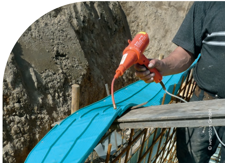
Bild 28: Kontrolle einer Fügung mit der Hochspannungsprüfpistole
