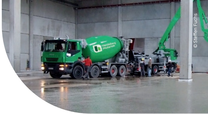
Bild 10: Herstellung Industrieboden
