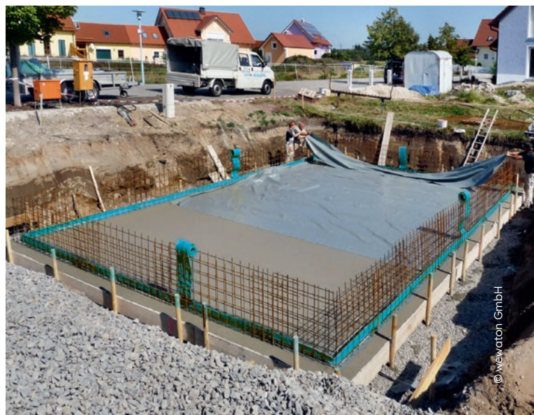
Bild 29: Fertig betonierte Bodenplatte mit vorbereiteten Fugenbändern
