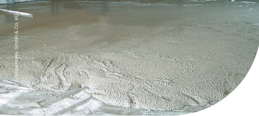
Bild 36: Einbau von Stahlfaserbeton: Industrieboden
