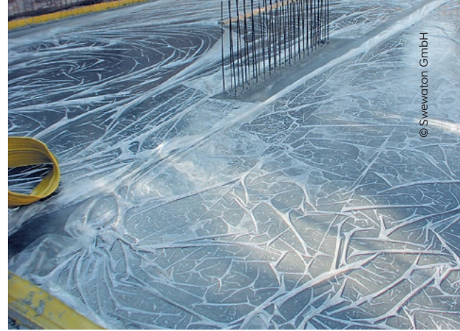
Bild 38: Nachbehandlung im Sommer: Schutz u. a. vor dem Austrocknen
