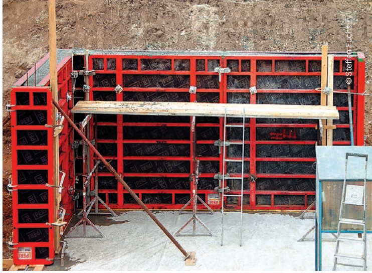
Bild 18: Einbau des Stahlfaserbetons in eine Kellerwandschalung
