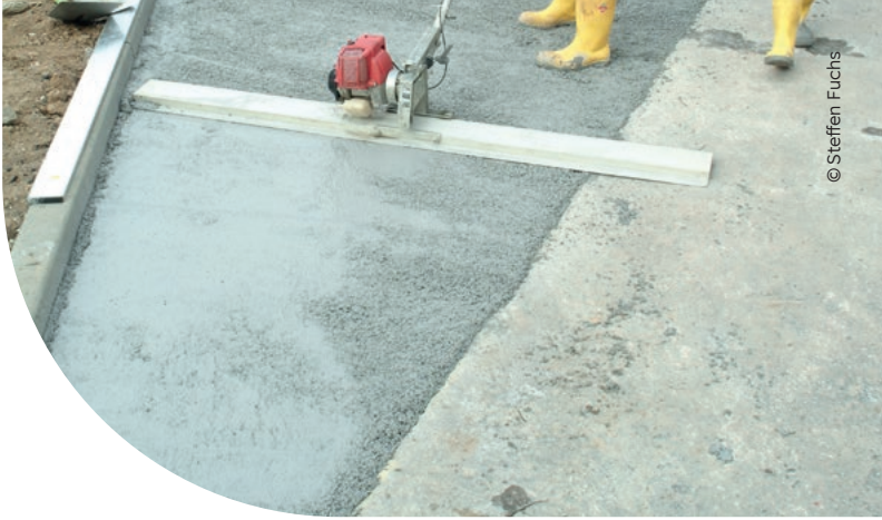
Bild 37: Oberflächenbearbeitung einer Bodenplatte aus stahlfaserverstärktem Stahlbeton
