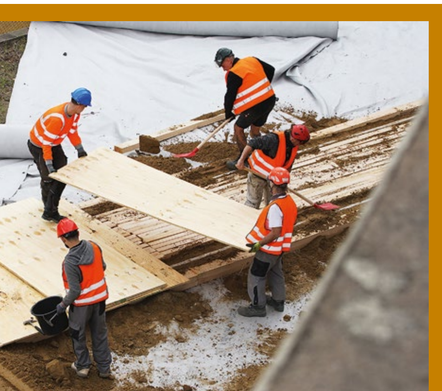
Die Gleise mussten ausgebohrt und mit Vlies bedeckt werden – über eine Fläche von etwa 4.000 Quadratmetern.
