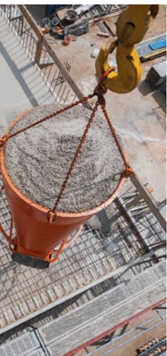
Das eingesetzte Betonsilo half dabei, den Beton vorsichtig dosiert einzubringen.
