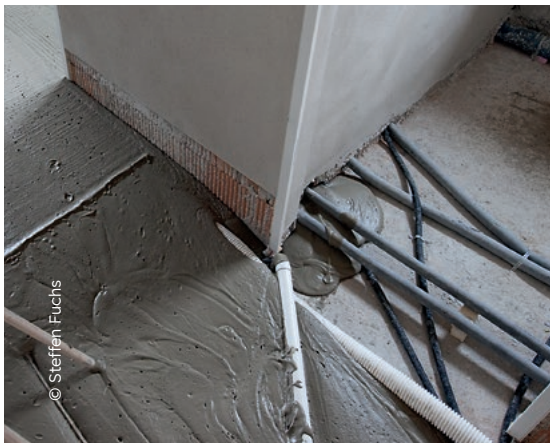
Sichere Einbettung von Rohren, Leitungen und Kanälen.
