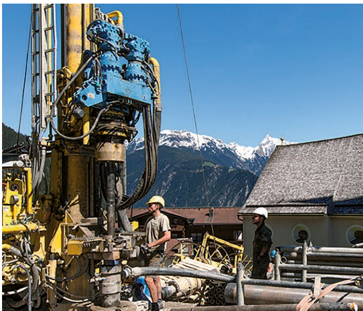
Bohrung für mitteltiefe Geothermie
