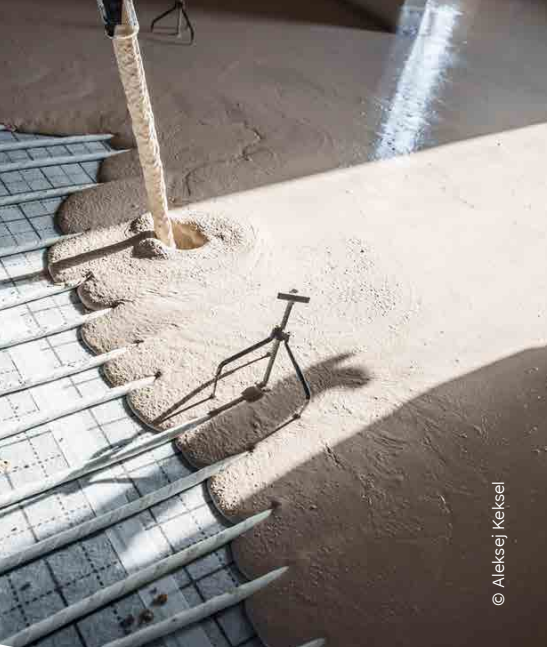
Anhyment umschließt die Heizrohre nahezu vollständig.
